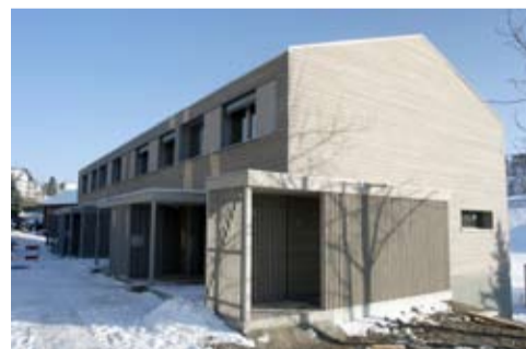
Nordwestansicht der Reiheneinfamilienhäuser
