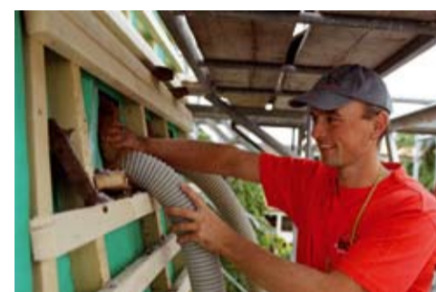
isofloc wird auch auf der Baustelle eingeblasen
