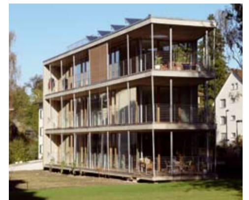
Erstes Minergie-P-Eco-Gebäude im Kanton Bern
