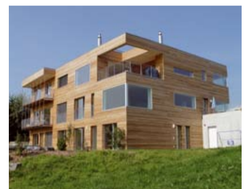
Mehrfamilienhaus in Fribourg
