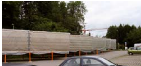
Die Elemente werden auf dem Parkplatz zwischengelagert
