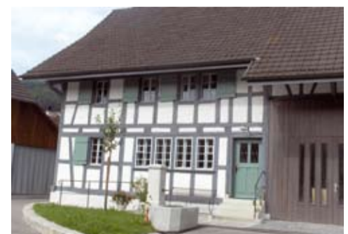
Sanierung: Objekt Urs Schmid in Wettingen
