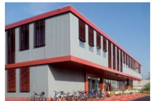
Elementbau: Paul Scherrer Institut (PSI) in Villingen
